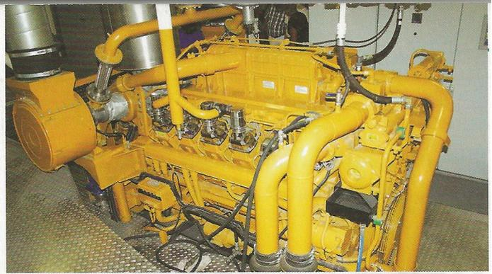
Deen betreibt die Caterpillar-Maschinen mit einer Mischung aus Diesel und Gas | Bilder: Nutsch
